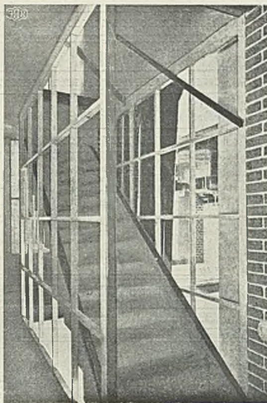
Widok na schody.
