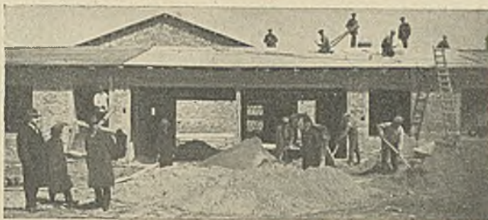
Budowa hali dla „Autoruchu” w Poznaniu przy ul. Marsz. Focha. Wyk. Przeds. budowlane J. PRZYBYŁ w Poznaniu.
