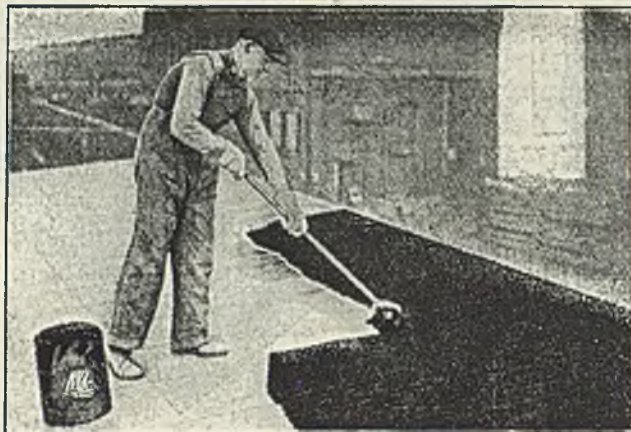
Trocal półgęsty na dachu
