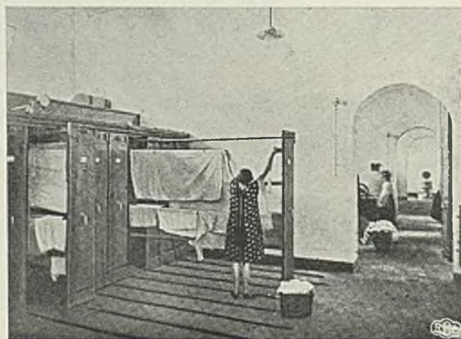
Rys. 16. „Sandeitleiten“. Szafka instalacja do suszenia bielizny w pralni.
