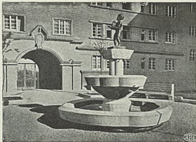
Rys. 1. „Sandleitn“. Studnia na jednym z dziedzińców.
