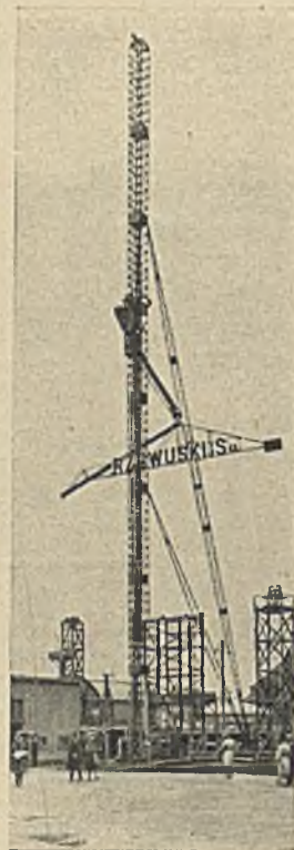
Maszt do betonu lanego
