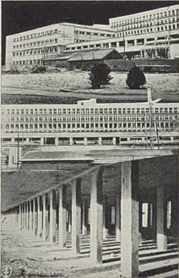
5 — 6. Arch.: Oeschger, Kaufmann i Hostettler. — Biblioteka krajowa i Urząd patentowy w Bernie. Zdjęcia z budowy. Rok 1930.
