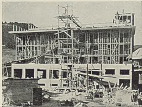
78. Arch. bracia Brunold. Hotel sportowy w Maran. Budowa ściany południowej — ryglówka, obłożona częściowo Ondulexem.
