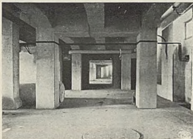
Podziemie. Uniezależnione od ścian i konstrukcji reszty budynku fundamenty maszyn rotacyjnych.
