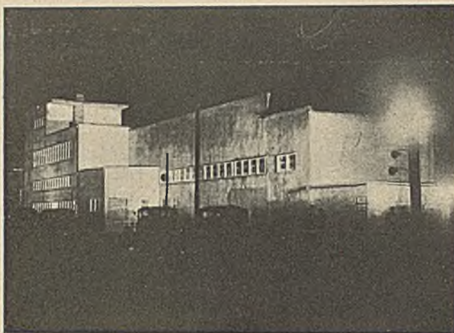
1. Arch. Lucjan Sikorski. Widok od ulicy Budynek klubowy.
