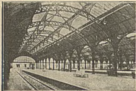
Hala peronowa gl. dworca w Kopenhadze.
