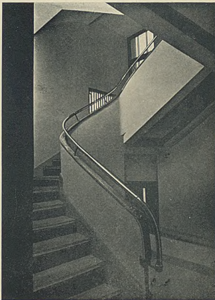
Klatka schodowa w skrzydle bocznym.
