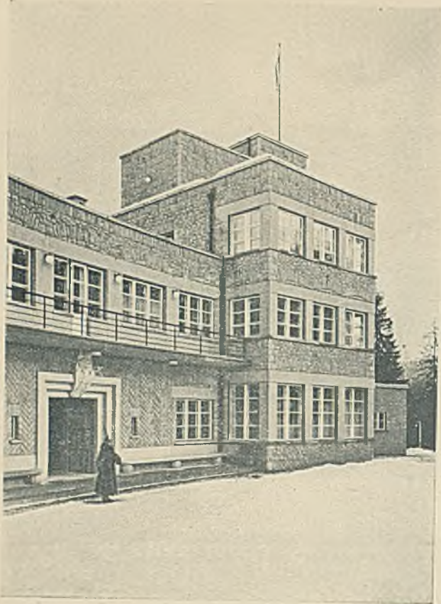
Fragment elewacji zachodniej.
