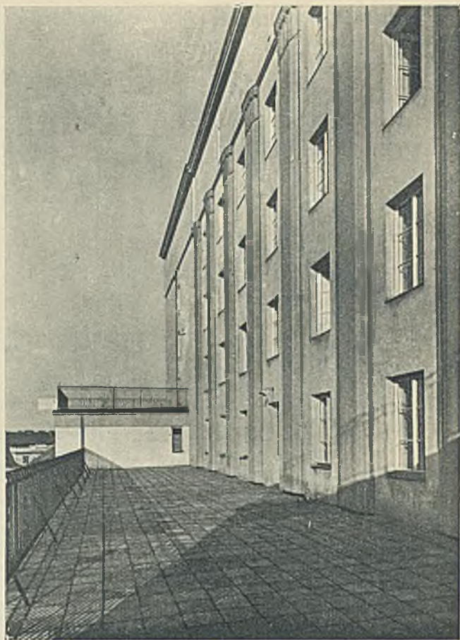
Taras na IV-em piętrze.
