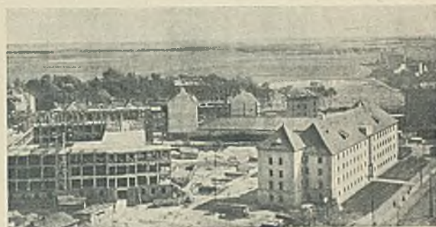
Fragmety z budowy.
