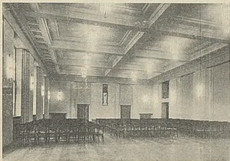
Sala Reprezentacyjna w Głównym Pawilonie Kolonji Akademickiej. Arch. Prof. K. Tołłoczko.—Wyprawa „TERRAZYT” obrobiona z dęta.
