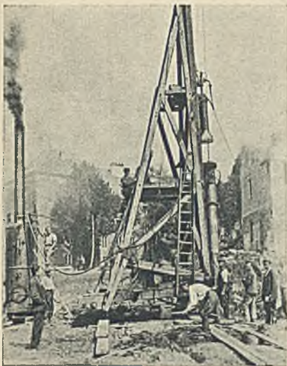
Zabijanie żelbetowych pali Sterna.
