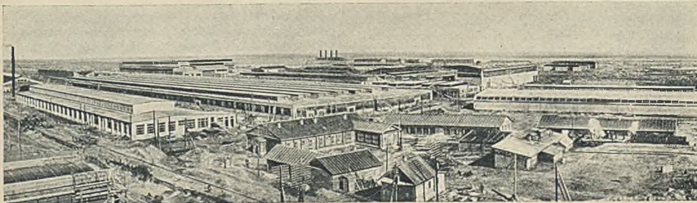
3. Widok fabryki traktorów, budowanej pod Stalingradem.
