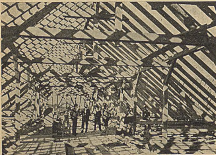
Izba Skarbowa w Poznaniu. Proj. arch. Polaszka. Roboty murarskie, ciesielskie, brukarskie wykonała firma „EDMUND RYCHLICKI”.
