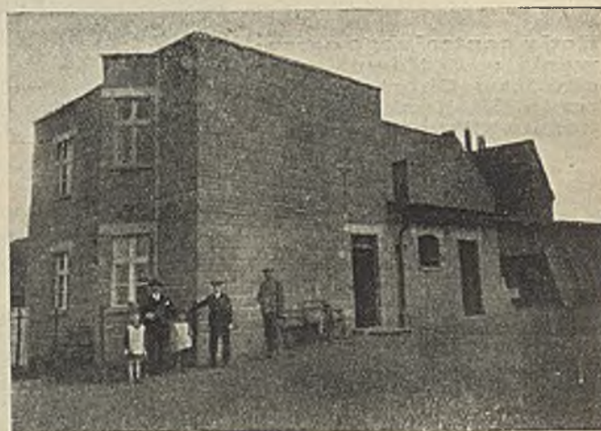
Budynek biurowy. Projekt i wyk. f. „Stanisław Schmidt“ w Toruniu.
