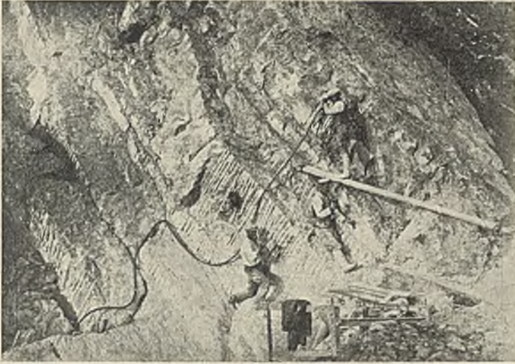
1. Kopalnia marmuru Bolechowice. Wydobywanie marmuru zapomocą pneumatycznych świdrów.
