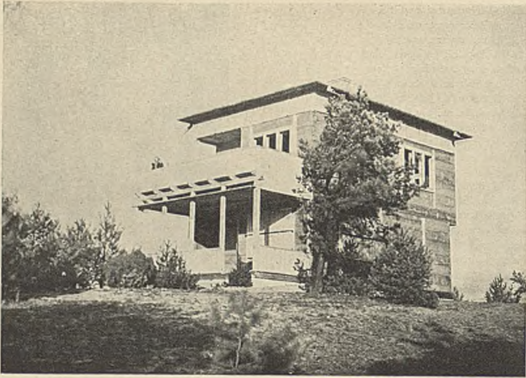
1—3. Arch. Mieczysław Łokcikowski (Warszawa). Dom drewniany nad Wisłą.
