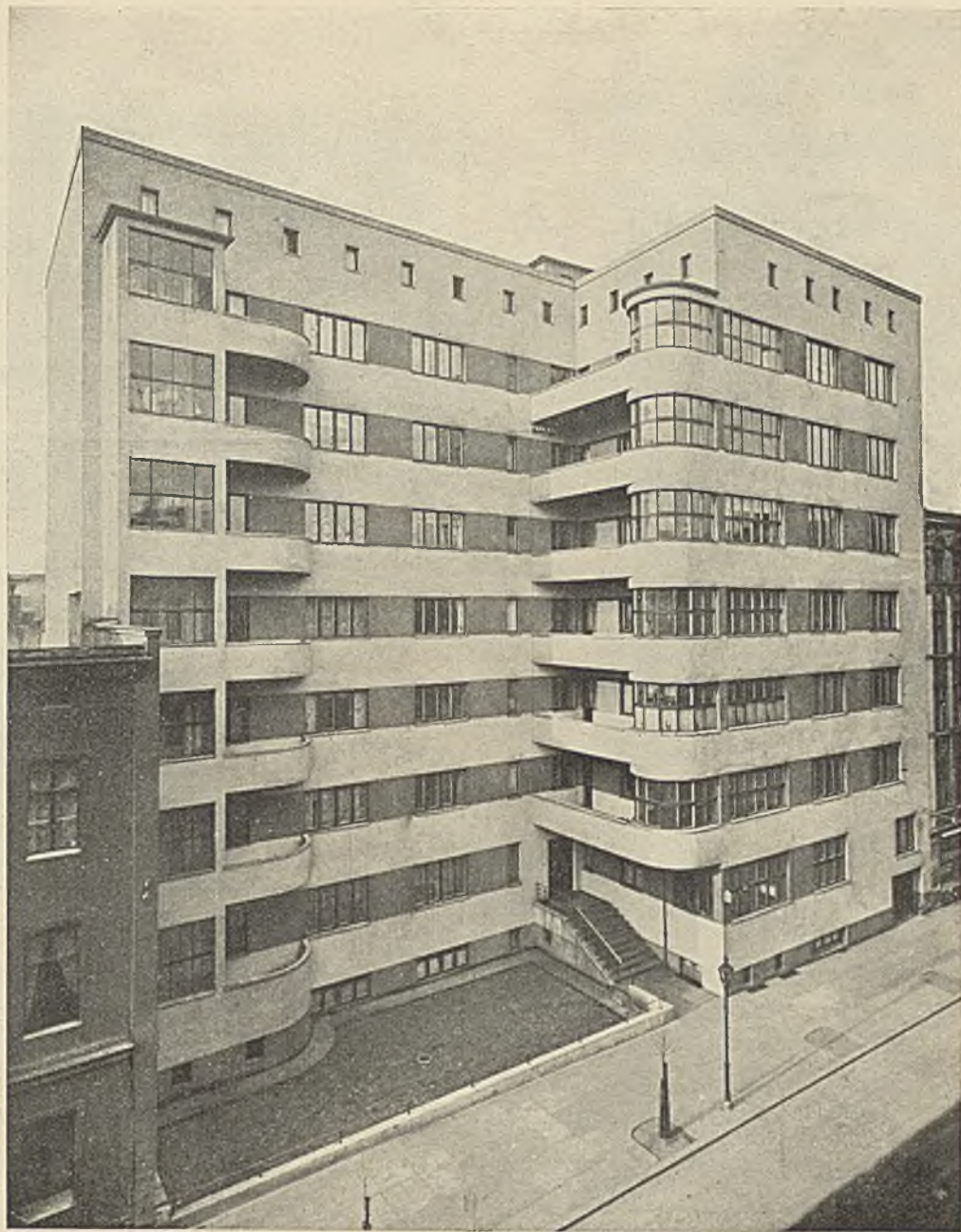
1. Arch. Tadeusz Michejda (Katowice). Dom mieszkalny Dyrekcji Kolei w Katowicach. Widok ogólny.
