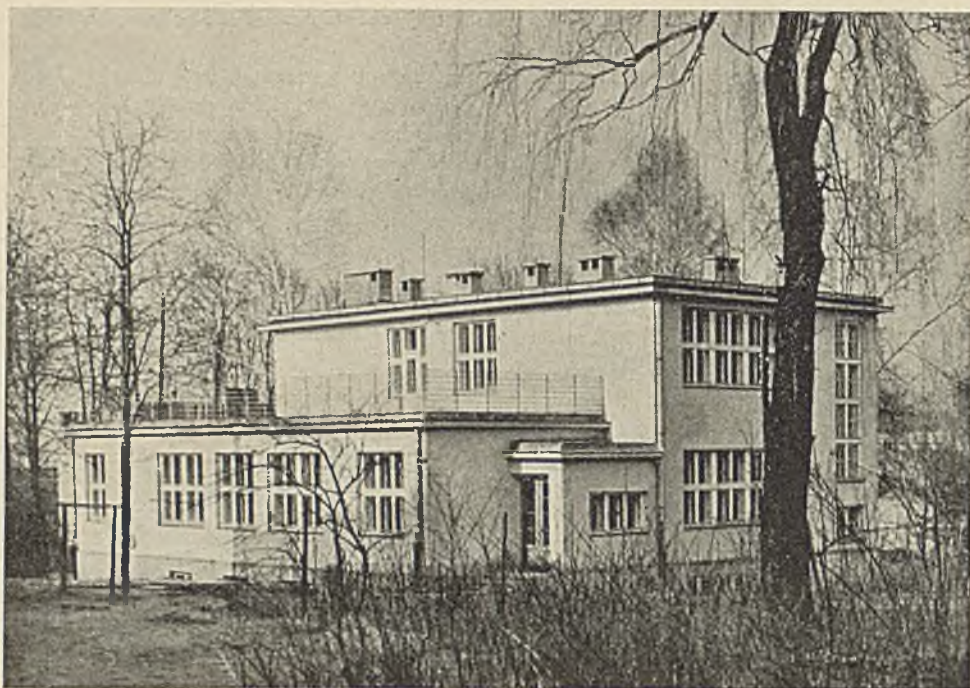
Urządzenie centralnego ogrzewania oraz instalację sanitarną wyk. f. „Termo“ Sp. z o. o. (Katowice).
