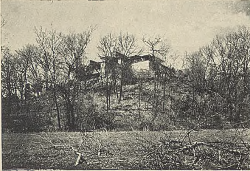
1. Arch. Frank Lloyd Wright. Taliesin, dom własny w Spring Green w St. Wisconsin, r. 1911—26.
