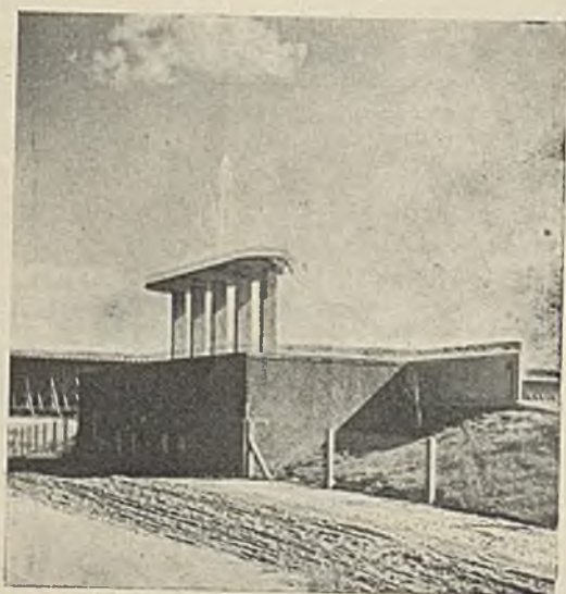
Budynek filtrów od strony wejścia.
