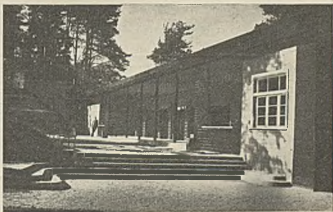
Widok szatni otwartej na poziomie wyższym (na I planie przechowalnia sprzętu sportowego).
