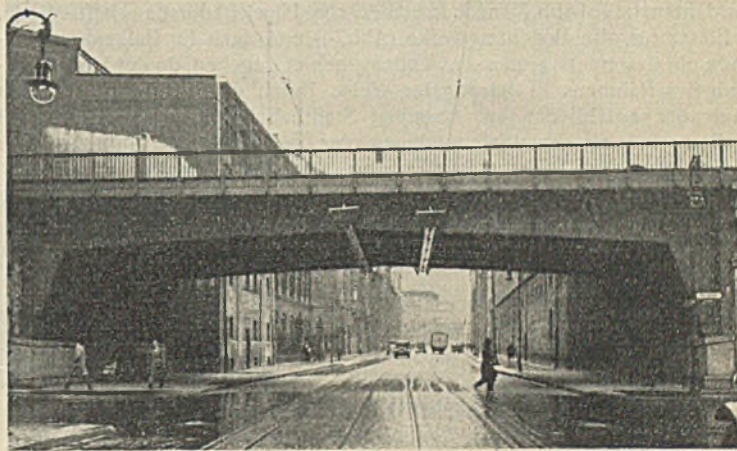
Abb. 2. Unterführung der Prinz-Friedrich-Karl-Straße.
