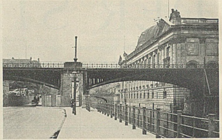
Abb. 5. Unterführung der Straße Am Kupfergraben. Alter Zustand.
