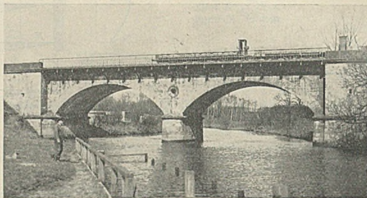
Abb. 1. Eisenbahnbrücke über die Wersse vor dem Umbau.
