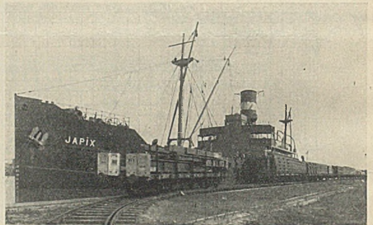
Abb. 27. Verladen der Konstruktionen vom Hafengrundstück der Firma Gollnow, Stettin .
