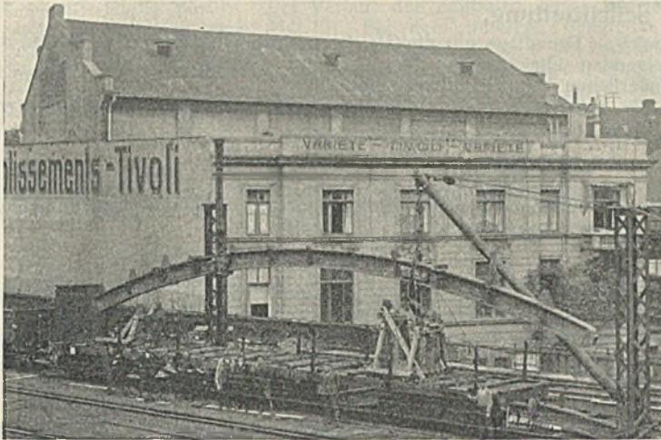
Abb. 3. Einbau der Bogenträger bei der Auswechslung der Schiffgrabenbrücke in Hannover in je 20 min Zugpause.
