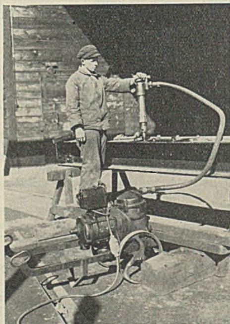
Abb. 5. Preßlufthammer mit Döpper.
