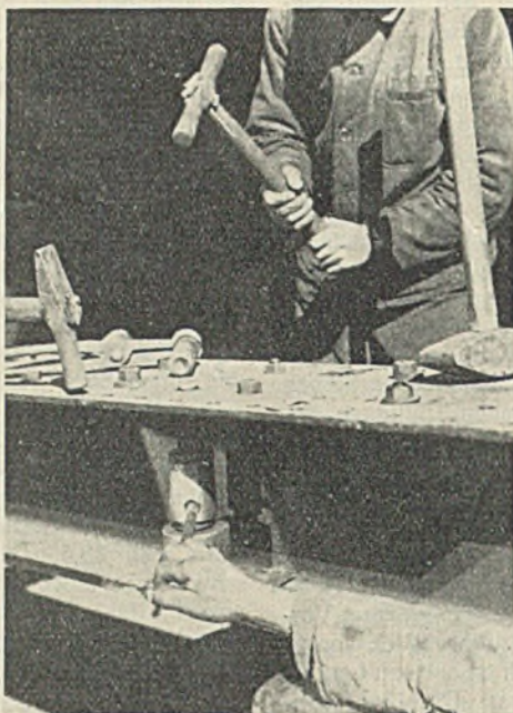
Abb. 1a. Vorstauchen mit leichtem Setz- oder Stauchhammer.
