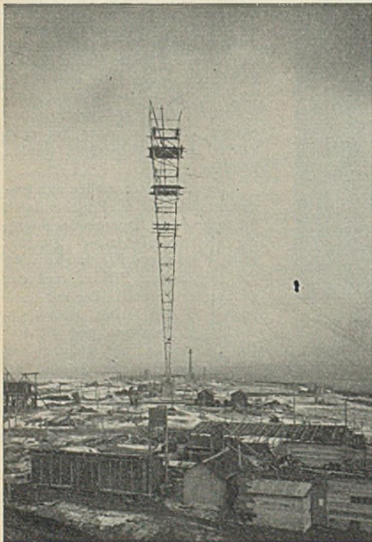
Abb. 2. Aufstellung des mit Hilfsabspannungen versehenen unteren Mastteiles.
