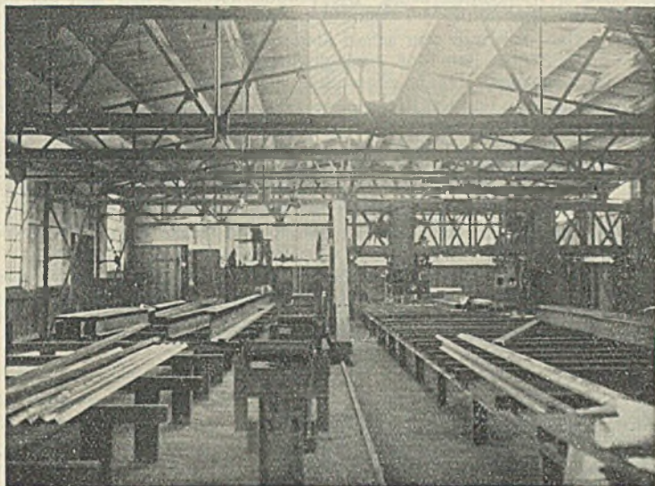
Abb. 1. Alter Zustand der Werkstatthalle.
