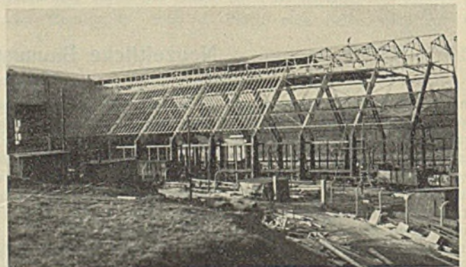
Bild 7. Stahlkonstruktion kurz vor beendeter Montage.
