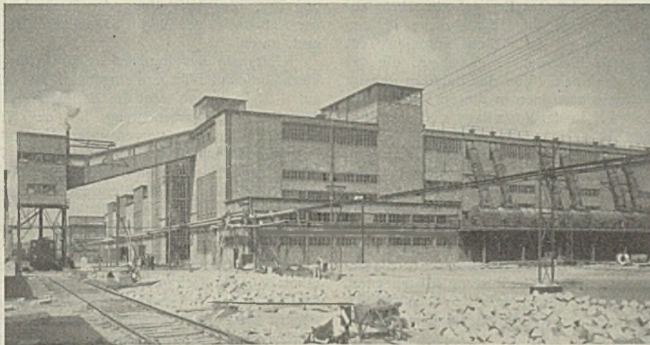
Bild 1. Gesamtbild der Zinkerzöstanlage, längsseitig.
