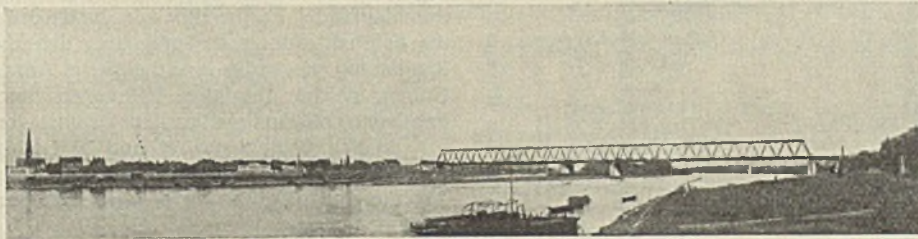
Bild 2. Die neue Rheinbrücke bei Neuwied.
