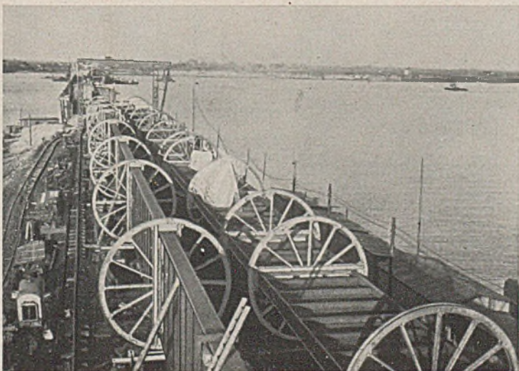
Bild 9. Baustellenschweißungen an Brückenträgern für die Rügendammbücke.
