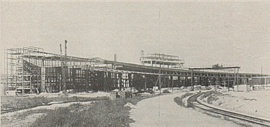
Bild 17. Die 380 m lange Flugsteighalle ist aufgestellt. In der Mitte das Stahlskelett des Gaststätten-Aufbaues, ganz links ein Treppenturm.
