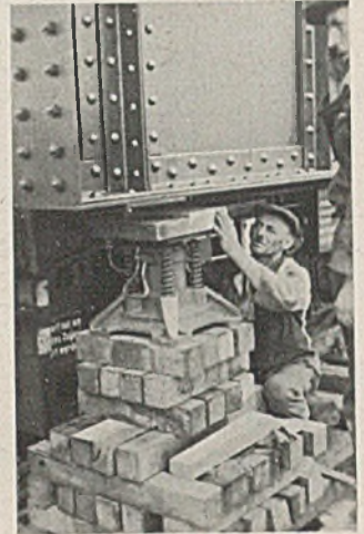
Bild 2. Ausbildung eines für die kontinuierliche Abstapelung benutzten Schwellenstapels mit aufgesetzter Pumpe.
