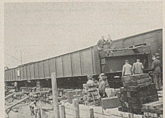
Bild 3. Absenken des Überbaues und Entfernung der unter demselben noch sichtbaren Hilfsträger und Stapel für die Gleissicherung.
