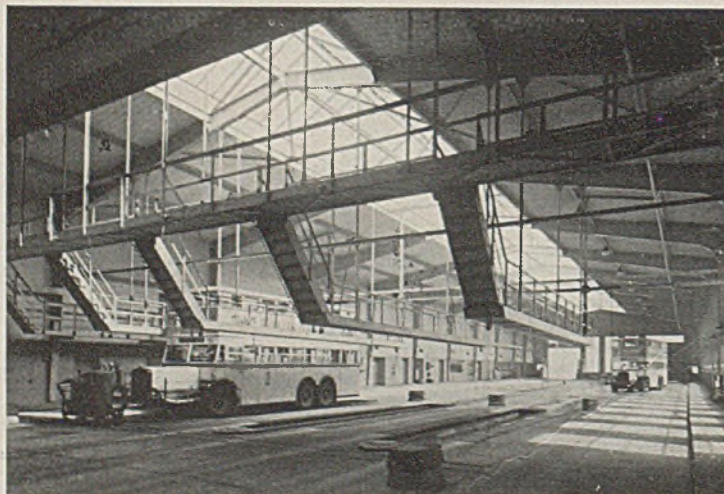
Bild 7. Halle I. Blick auf die Putzgerüste und die Revisionsstände.
