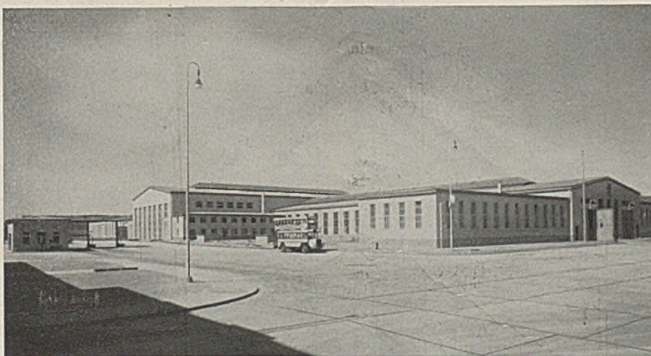
Bild 4. Ansicht der Gesamtanlage von der Einfahrt aus gesehen.
