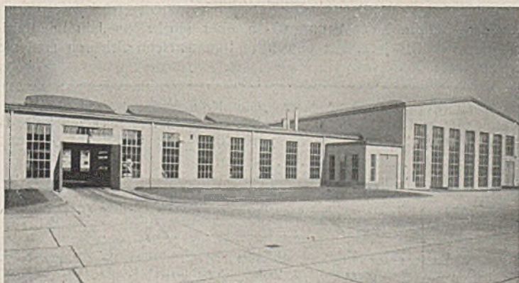
Bild 19. Halle III. Außenansicht und Anschluß an Halle II.
