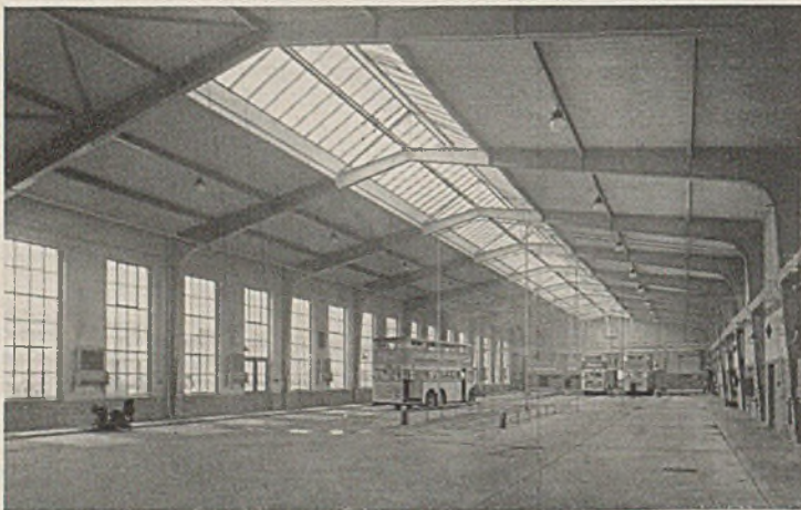
Bild 6. Halle I. Blick von der Einfahrt aus auf die Waschstände.
