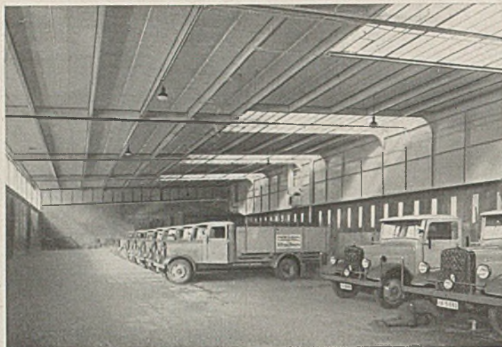
Abb. 17. Innenansicht einer Seitenhalle.
