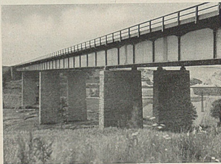
Bild 28. Ansicht der Brücke von Norden.
