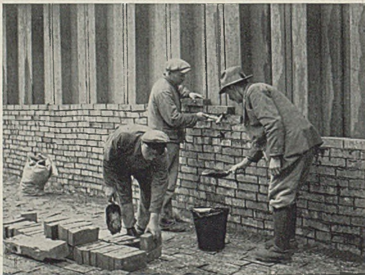
Bild 18. Ein Klinkertrog schützt das Fundament des Pfeilers 2.
