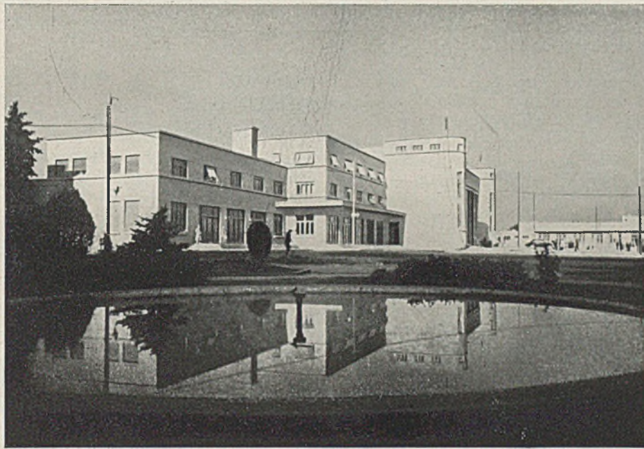
Bild 1. Vorderansicht des Empfangsgebäudes.
