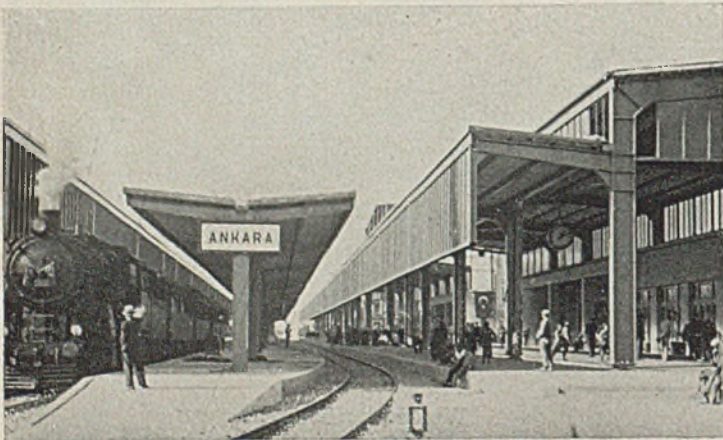
Bild 12. Blick gegen das östliche Ende des Bahnsteiges 1 (rechts), des Gepäckbahnsteiges (Mitte) und des Bahnsteiges 2 (links, Schürze).
