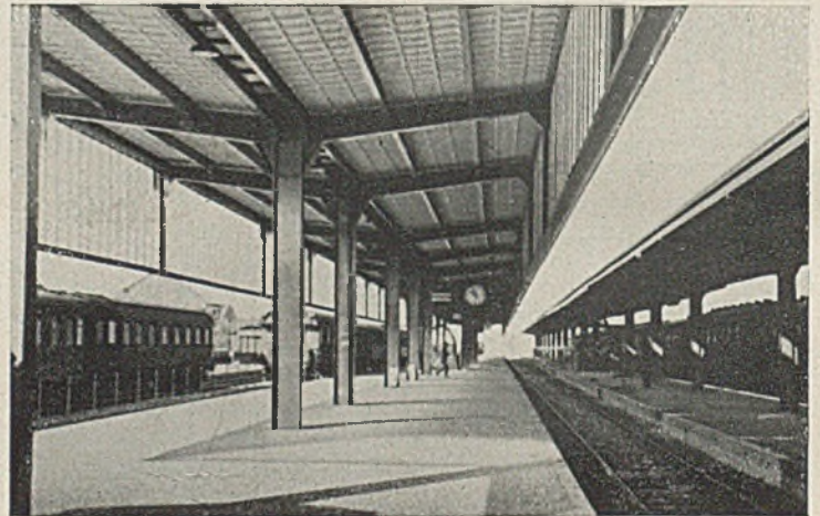
Bild 13. Überdachung des Bahnsteiges 2 (halblinks) und des Gepäckbahnsteiges (rechts).
