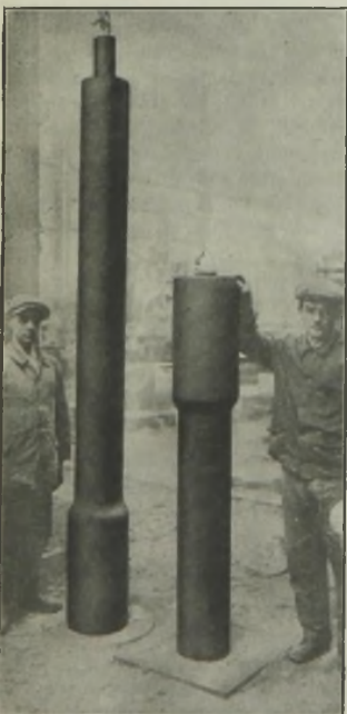
Abbildung 1. Zweiteiliger Kern. 240/320 mm Dmr., 5400 mm lang für eine Hohlwalze von rd. 20 t Gewicht.
