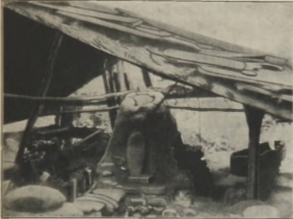
Abbildung 3. Hochofen in Lawitschtängä. Im Vordergrund die Röststadel, rechts der Trog für den Schrot, links der Blasebalg.
