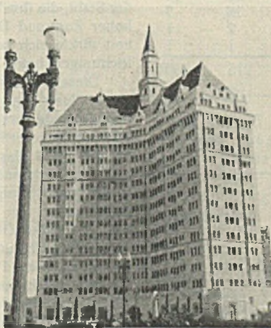
Abb. 3. Villa Riviera, ein völlig unversehrter Stahlskelettbau.
