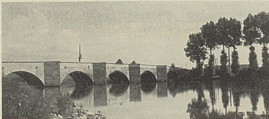
Bild 41. Mittelalterliche Straßenbrücke über den Neckar bei Köngen.
