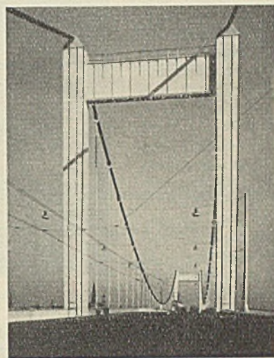
Bild 33. Pylone der Rheinbrücke Köln-Mülheim.
