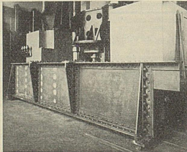
Bild 4. Ansicht des genieteten Trägers.
