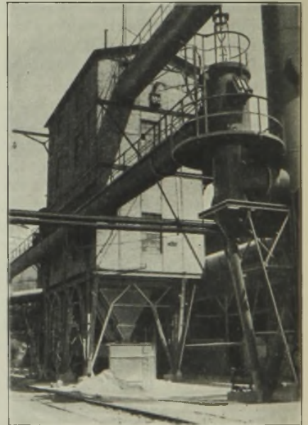
Abbildung 6. Gesamtansicht der Reinigungsanlage.
