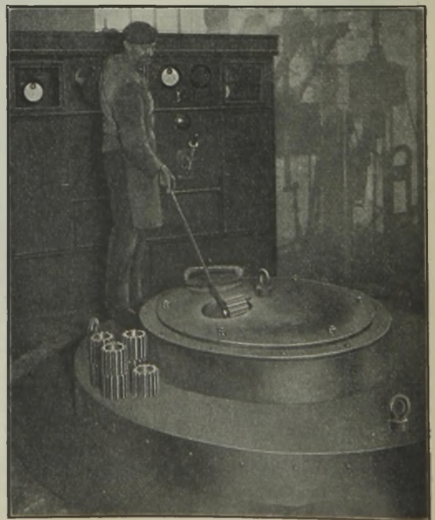
Abbildung 9. Rundglühofen. Beschicken mit großen Zahnrädern durch zwei Krane.
