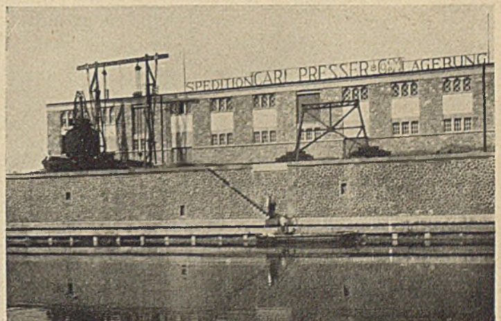
Abb. 4. Ansicht der Ufermauer bei gesenktem Wasserstau.
