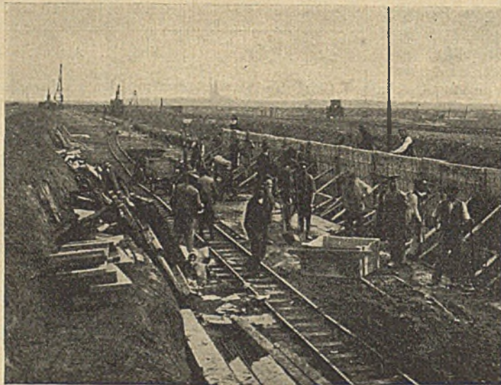
Abb. 15. Bau des Kranholms.
