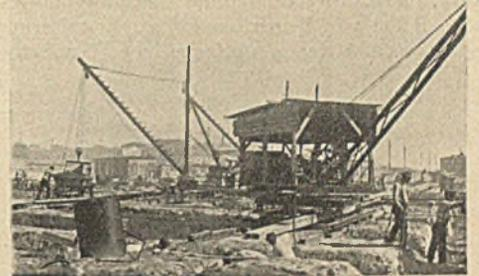
Abb. 11. Aushub der Fundamente für die Fischhallen 5 u. 6.
