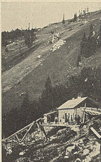
Abb. 3. Arbeiterwohnbaracke und Hilfsseilbahn.
