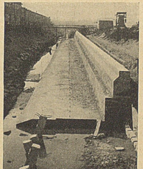
Abb. 17b. Kaimauer im Fischereihafen Cuxhaven. Ansicht der teilweise fertiggestellten Betonmauer.
