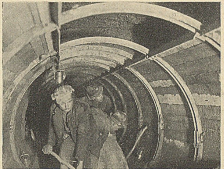
Abb. 40. Zweiteilige, eiserne Lehrbogen mit Holzverschalung. Im Scheitel Blechtafeln, quer verlegt für Gewölbeschluß.
