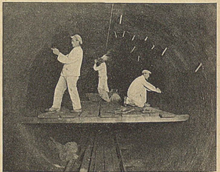
Abb. 5. Röhren zur Abführung des Sickerwassers in das Stolleninnere, um das Torkretieren zu ermöglichen. Glattstreichen des aufgetragenen Torkrets.
