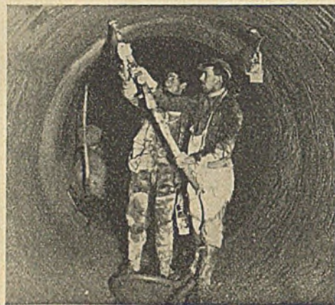
Abb. 43. Mörtel-Hinterpressungen mit „Injektionsapparat, System Torkretgesellschaft“.
