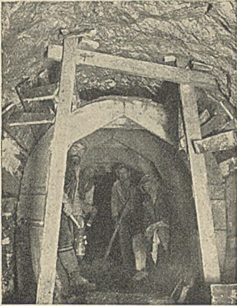
Abb. 35. Holzverschalung mit kurzen Querbrettern im „Scheitel“ für das „Vor-Kopf-Betonieren“.
