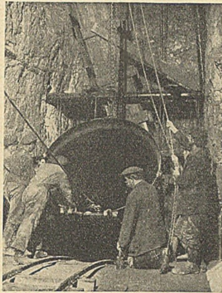
Abb. 46. Herablassen eines eisernen Verkleidungs-Rohrstückes im Druckschacht.
