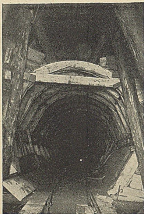
Abb. 60. Besondere Abstützung bei Mehrausbrüchen über 1 m. Hölzerne Lehrbogen.
