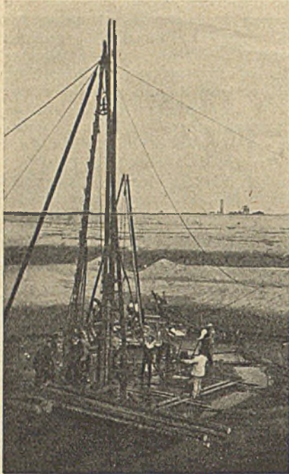
Abb. 1. Rammen unter gleichzeitigem Spülen.
