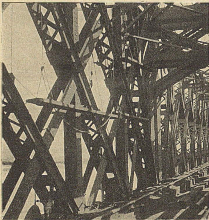
Abb. 3. Teilaufnahme nach der Verstärkung.
