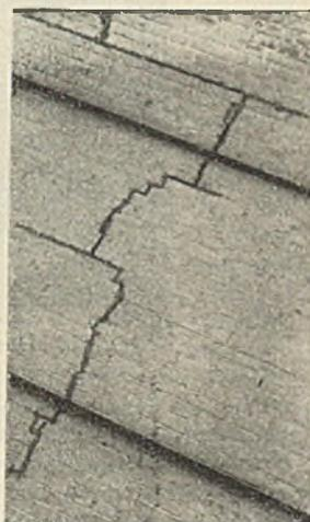
Abb. 5. Riß im Bogen 350 an der Lüneburgerstraße. Alte Ankereisen zur Verankerung d. Stirnmauern.
