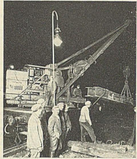
Abb. 30. Auslegerkran (elektr. Antrieb).
