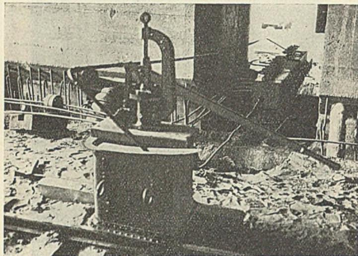
Abb. 35. Pumpe und Ventilkasten für die hydraulischen Pressen.
