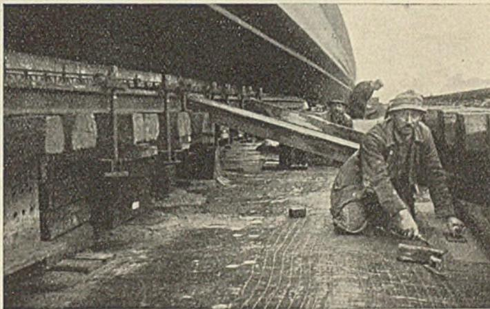
Abb. 27. Aufbringen der Monierschutzschicht.
