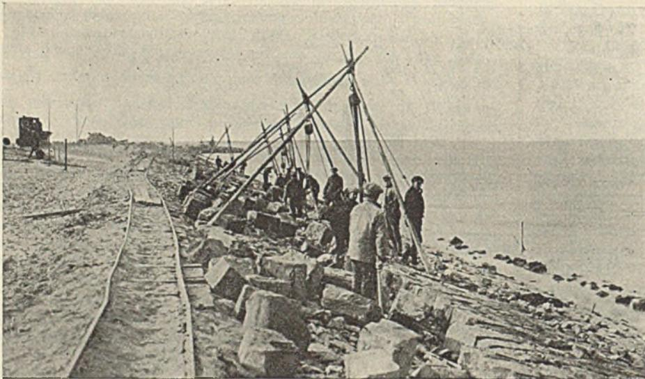
Abb. 11. Herstellung der Steinböschung.
