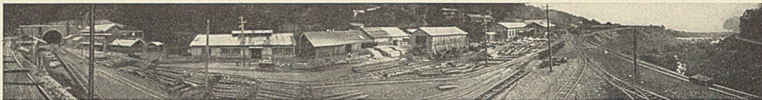
Abb. 8. Baustelleneinrichtung am Tunnelportal Atami.
