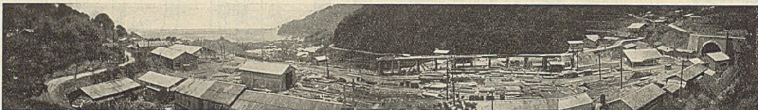
Abb. 9. Baustelleneinrichtung am Tunnelportal Atami.
