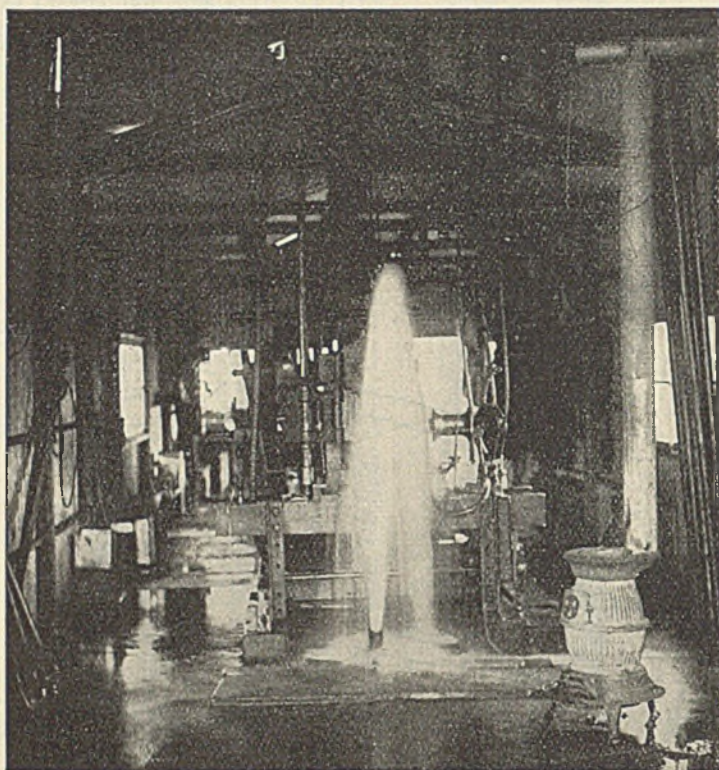
Abb. 7. Wasseraustritt beim Bohren in der Tanna-Senke. Höhe der Wassersäule ungefähr 7 Fuß. Entfernung des 1\frac{1}{2} zölligen Bohrrohres 130 m von Sohlenoberkante.
