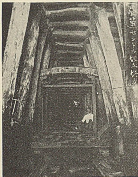
Abb. 21. Stollenvortrieb an der Verwerfungsspalte auf der Numazu-Seite.
