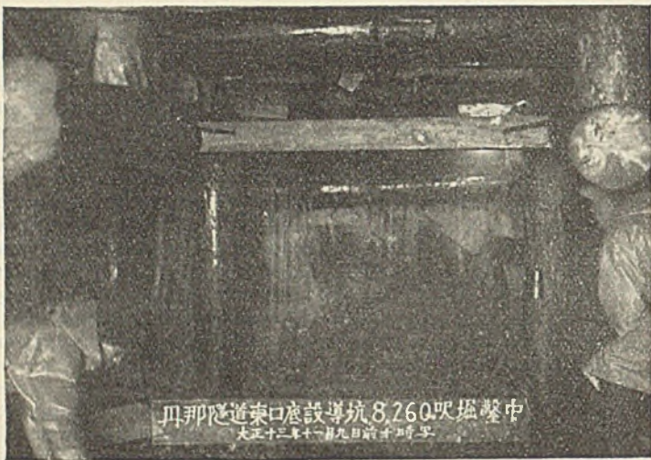
Abb. 16. Großer Wasserandrang im Vortriebstollen bei einem Verwerfungsspalt an der Atami-Seite.
